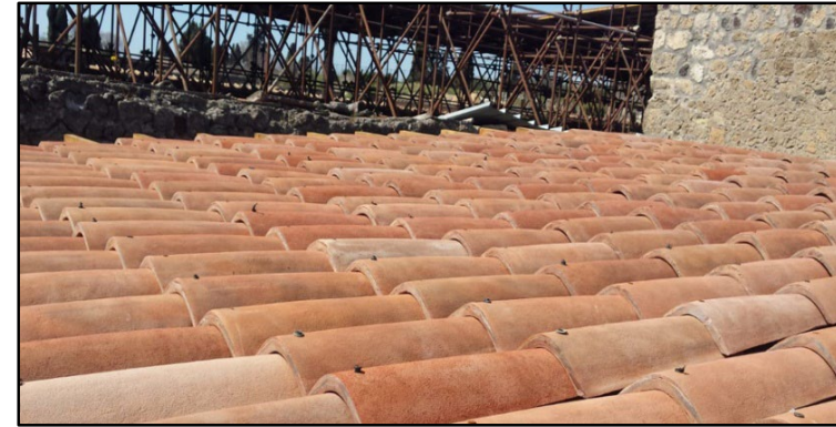
Montaža fotovoltaičnih strešnikov Tegola v mestu Evora (Portugalska). (Vir: Georgios Tsoumanis, 2021).
