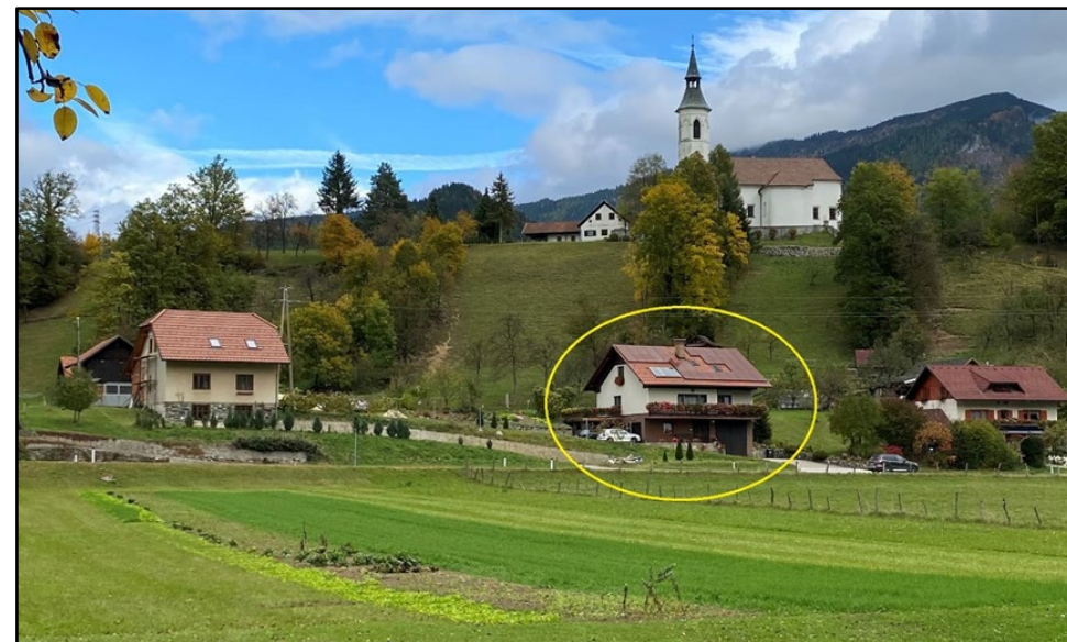
Primer vgradnje fotovoltaičnih modulov v vplivnem območju kulturnega spomenika z ustrezno barvo in strukturo ter neustrezno kompozicijo. (Vir: ZVKDS, 2023).
